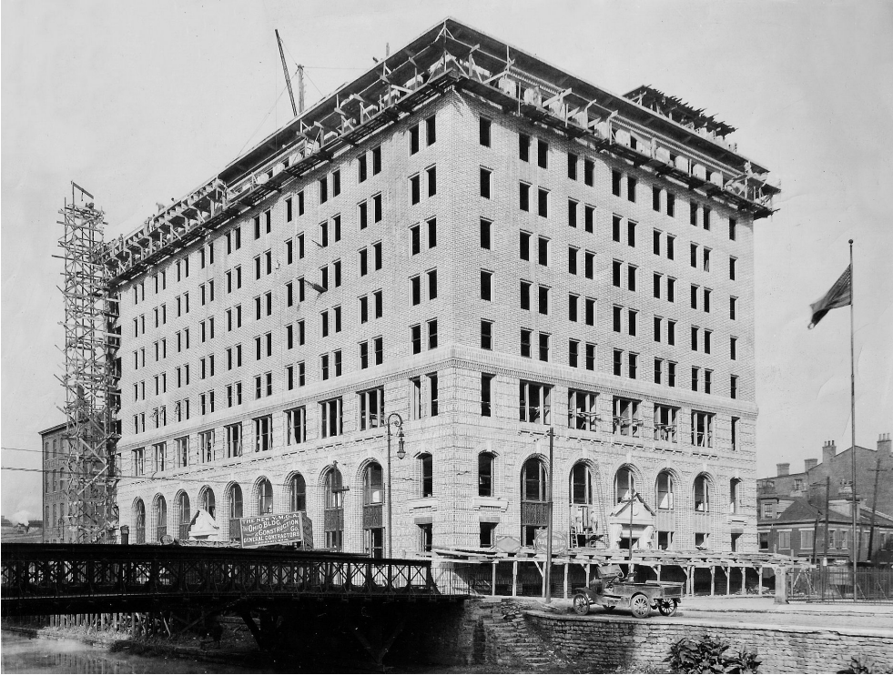
YMCA Cincinatin keskuksen rakennustyöt Ohiossa 1871
